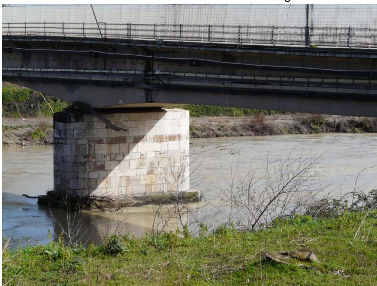
Figura 5: Uno dei piloni del ponte Garibaldi
