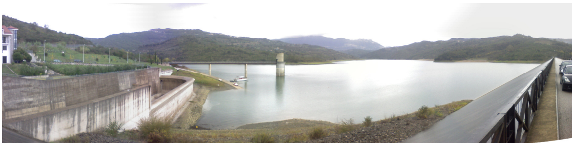
Diga di Piano della Rocca, invaso dell'Alento - immagine dallo sbarramento orientata verso monte.
