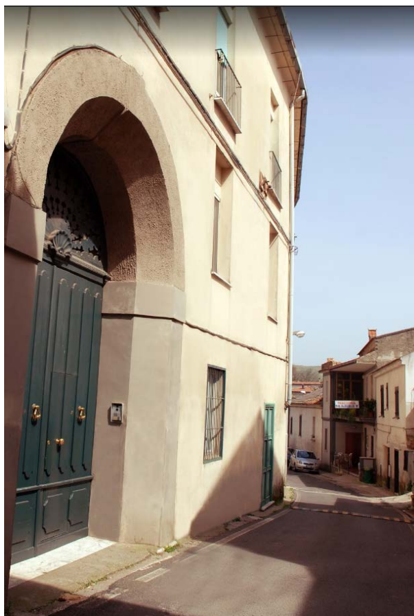
Facciata principale di Palazzo Alzone
